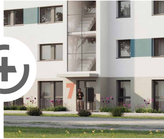
Pfosten-Riegel Treppenhaus
